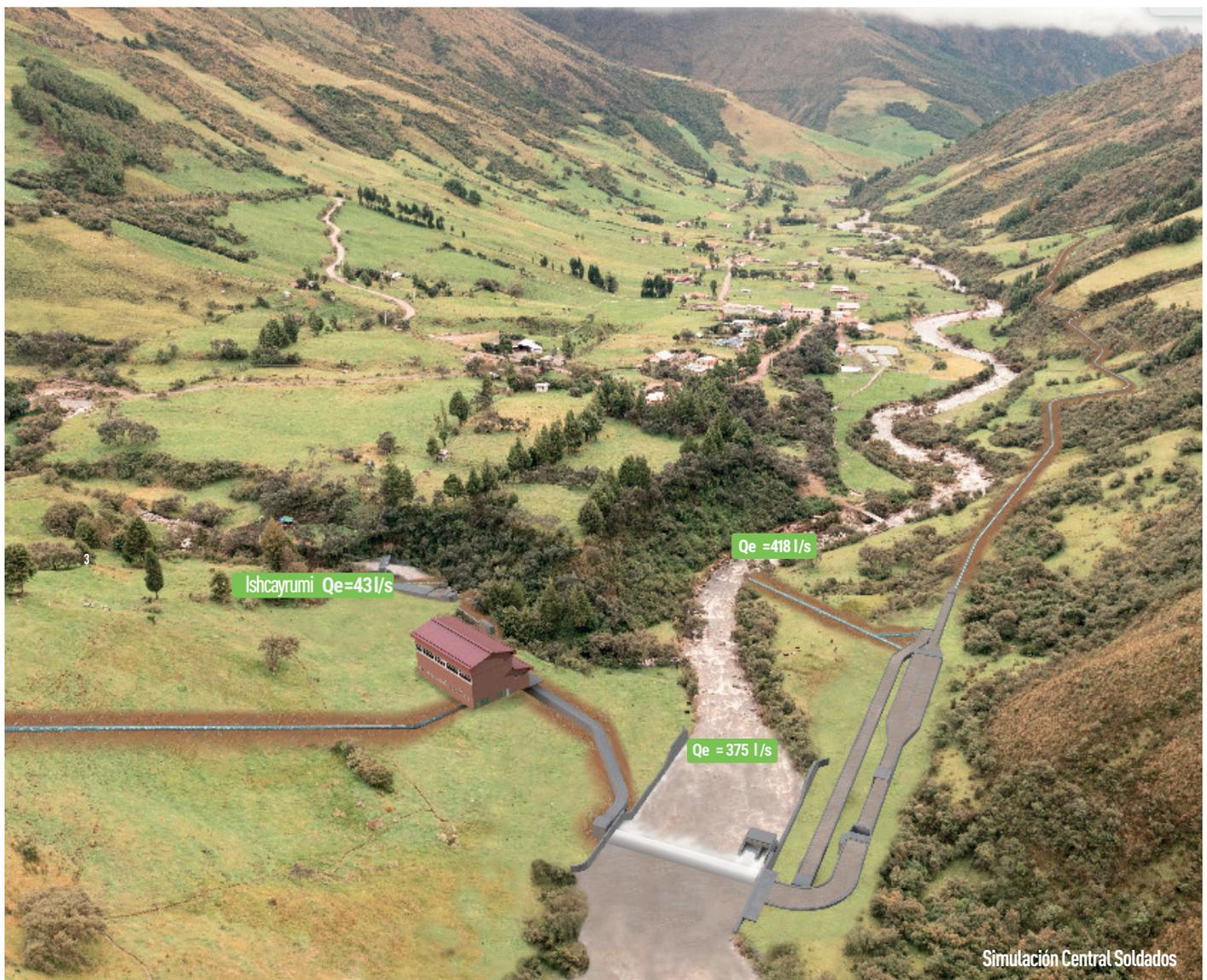
La captación para la Central Hidroeléctrica Soldados se hará directamente desde el embalse y la conducción estará compuesta en su totalidad por tubería enterrada con una longitud de 7,6 km. Al pie del embalse se garantizará un caudal ecológico de 210 l/s. Cuando la conducción pasa junto al río Galgal, en época de invierno se suma su aporte, respetando un caudal ecológico de 37 l/s.
